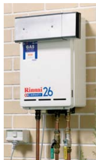
Flue Diverter
